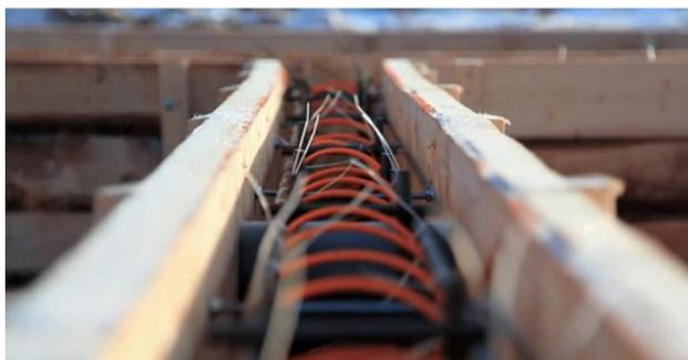
Рис. 4. Индукционный прогрев бетона в зимнее время
