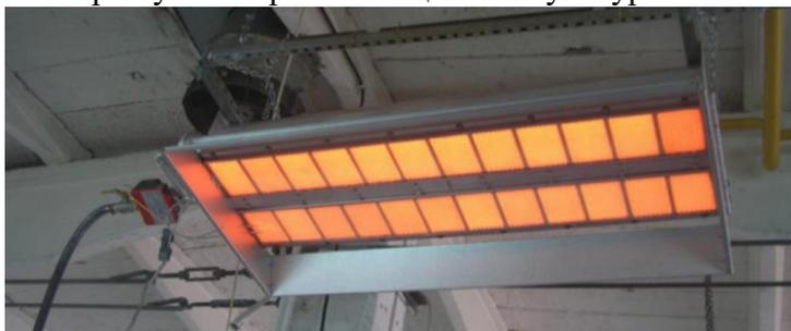
Рис. 3. Инфракрасного прогрев бетона
